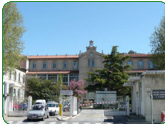
Accès par l'avenue Julien Fabre
